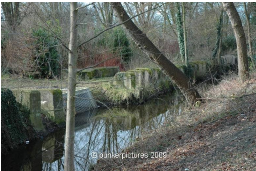
Slootgedeelte beveiligd met drakentanden
