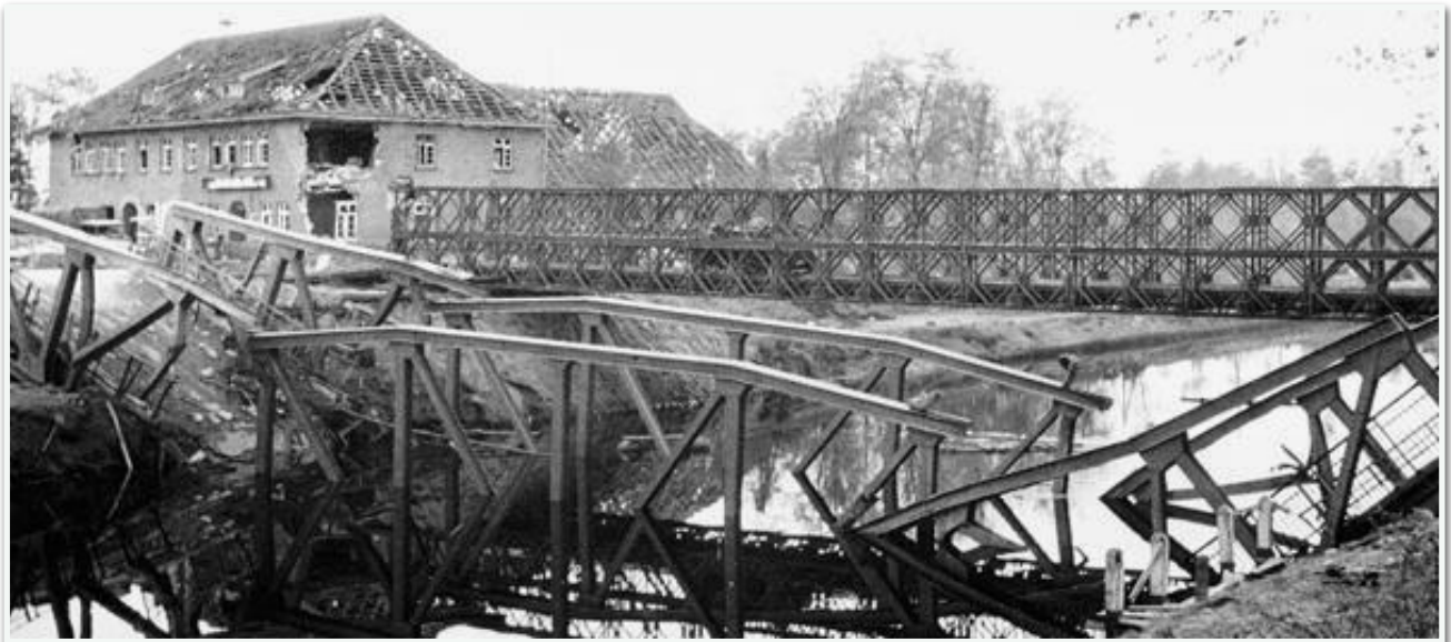
De door de Duitsers opgeblazen Edewechterdammerbrug over het Küstenkanaal
